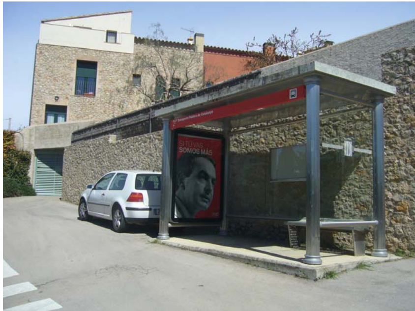
Foto 7. Parada de bus escolar a la GI-631
